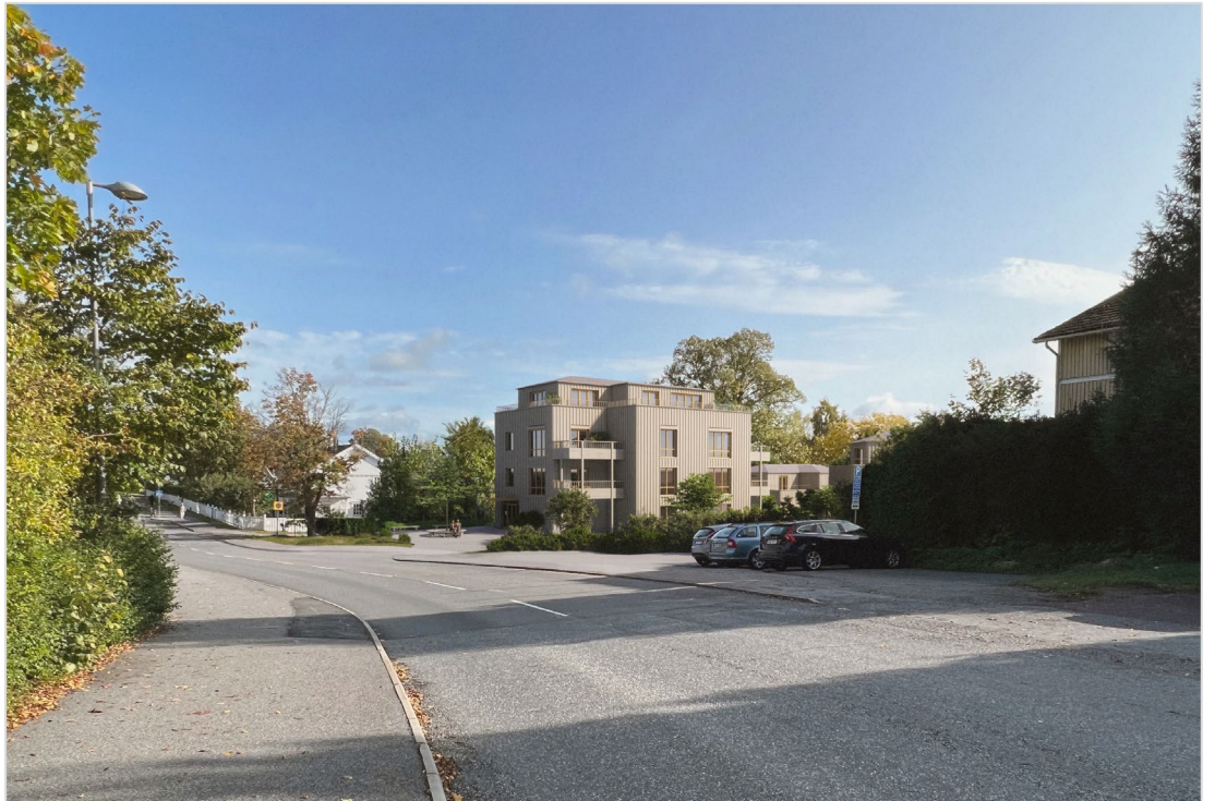
Samrådshandlingen: Vy från Manfred Björkquists allé, mot Stora gatans mynning och in mot Sigtuna. Mitt i bild ses det föreslagna Hus 3 inom fastigheten Guldet 17.
