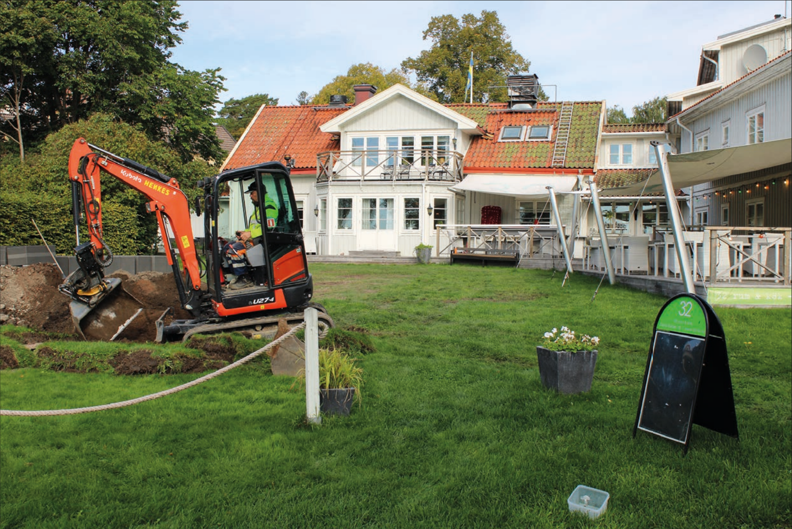
Figur 5. Schaktning på södra sidan av undersökningsområdet. Foto från söder.
