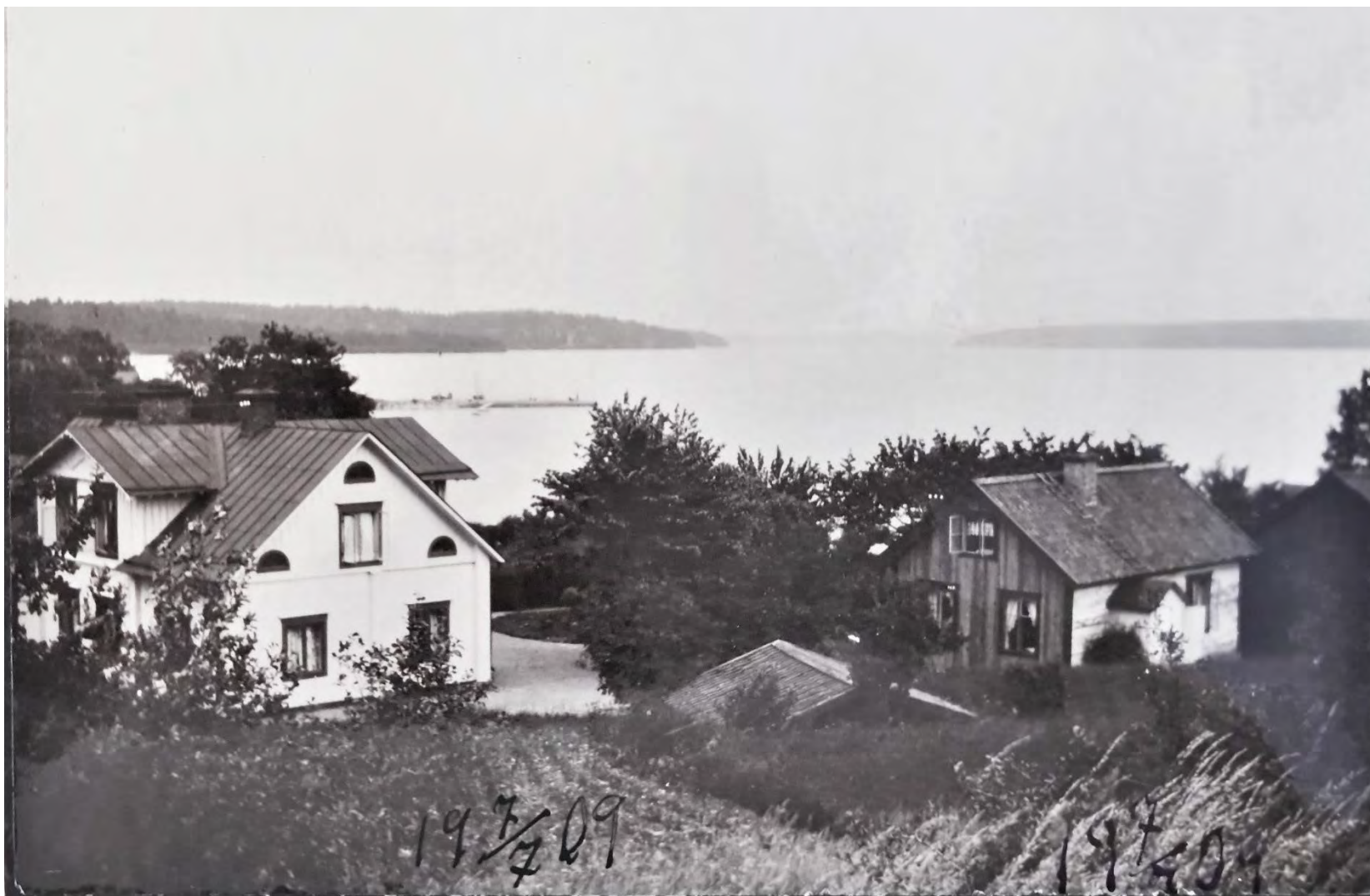
Fotografi på Kapten Johanssons villa, med Mälaren i bakgrunden år 1909. Huvudbyggnaden ligger till vänster i bild och till höger finns ett mindre bostadshus som vid tiden hörde till anläggningen. (Byggnaden ligger kvar än idag, men här nu till grannfastigheten.) Mellan de båda bostadshusen ligger en stenkällare och längst till höger i bild anas gaveln på en ekonomibygnad. Framför huvudbyggnaden finns en gräsrunnel och i övrigt är marken där grusad. Fotot ingår i Arvid Drakes fotosamling. Källa: Sigtuna Museum.
